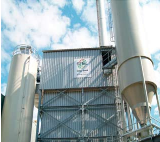
»1 Regenerative thermal oxidizers for volatile organic compounds »1 Thermisch regenerative Nachverbrennungsanlagen für flüchtige Kohlenwasserstoffe
