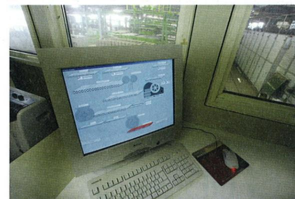
Figura 3: Estación WinCC en la sala de distribución: desde un ordenador Simatic WinCC en la sala de distribución es posible manipular y observar de forma centralizada el complejo proceso de fabricación de los ladrillos y tejas
