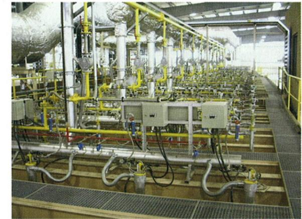
Figura 3: Vista sobre el horno túnel – al frente pueden reconocerse los grupos de quemadores de reducción
