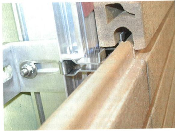
»6 Sistema di connessione con molle in acciaio fissate su montanti di alluminio
