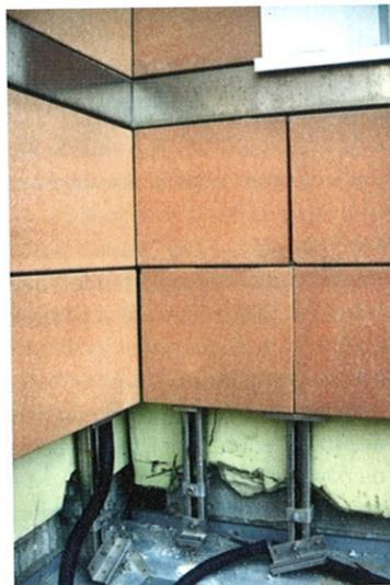
»2 Fasi di montaggio degli elementi di rivestimento in laterizio con individuazione dello strato isolante e dell'integrazione impiantistica
