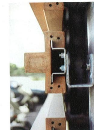
»8 Dettaglio dell'ancoraggio metallico di un elemento in laterizio
