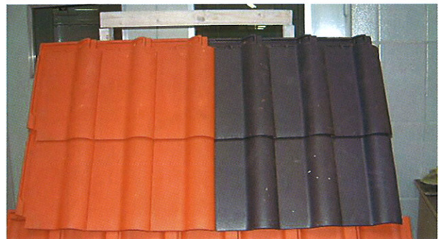
图7 粘土瓦铺设的样板
