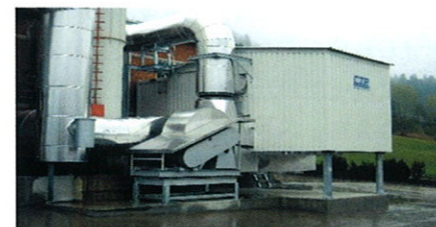
图1 RTO-3床25860kg/h紧凑型气体净化系统——用于砖瓦工业成孔工艺
