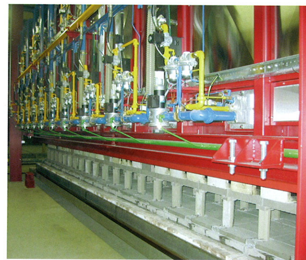
帽顶窑的侧面——上部正在被吊起
