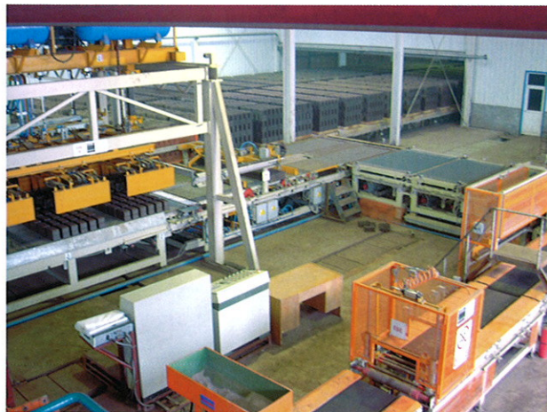
安装在河北省的设备概貌
