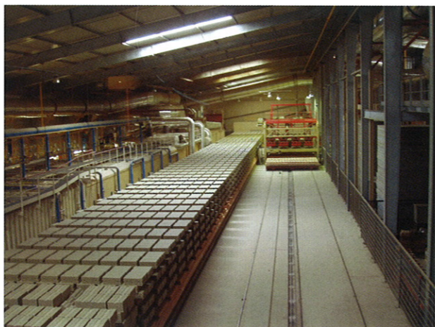
图7: 隧道窑和存车轨道
