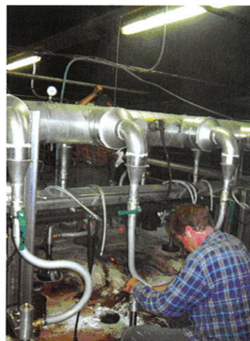
图 4: 双燃料高速烧嘴装置
