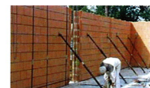
图5 带直立支撑的墙板构件(来源:B2)
