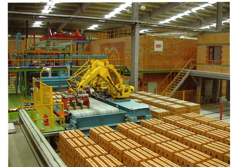
码坯垛机器人和辊道干燥室
