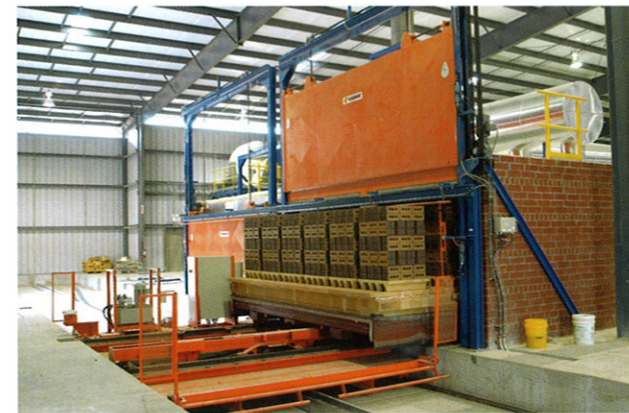
过渡室进口处
