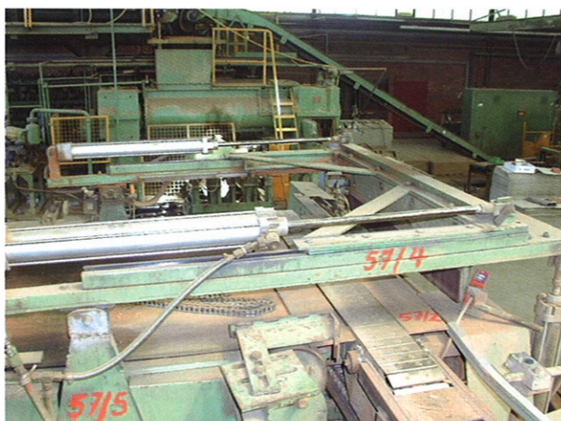
2. 在拆除旧机器前, 所有部件都要先进行标记
