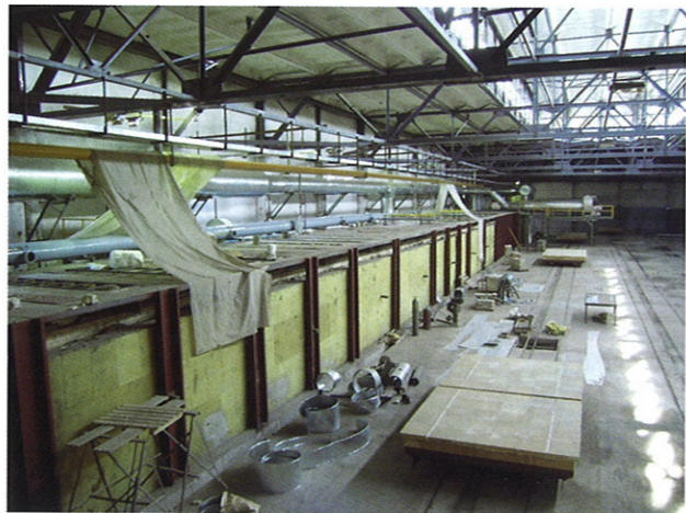
13. 建造中的隧道窑
