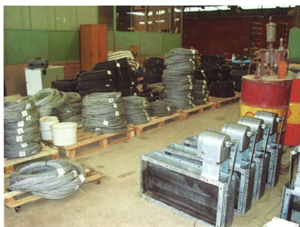
3. 不仅仅是旧设备, 线缆也要拆除和装运
