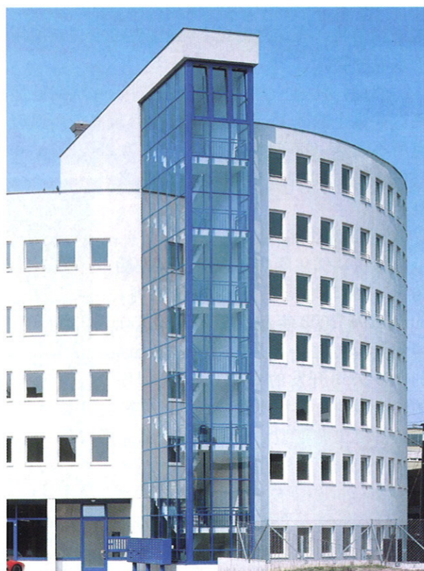
图 1: 砖结构的多层住宅建筑
