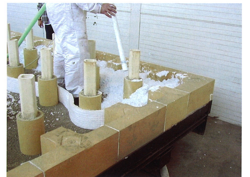
图3:泡沫纤维可以均匀填充、无间隙,因而可以大面积快速安装
