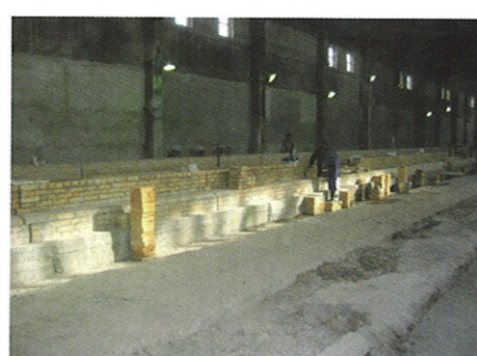
12. 隧道窑被重建成砖石结构
