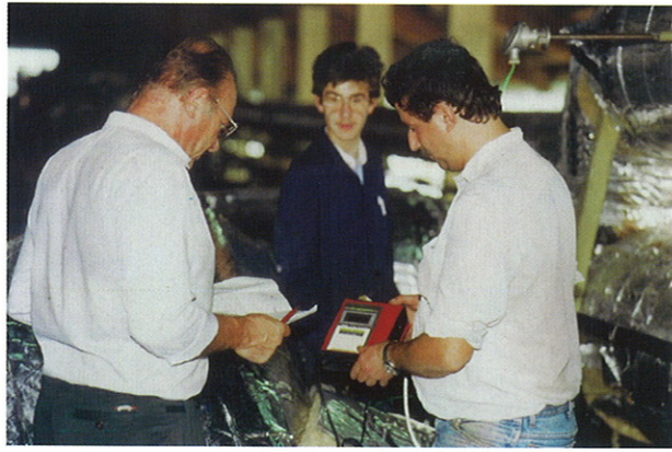
图 10 精确温度测定及换热器效率确定
