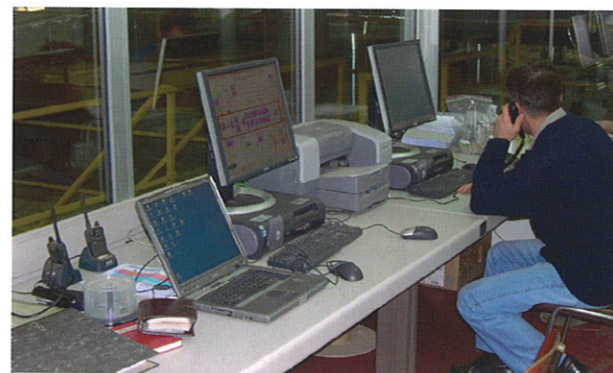
图 8 干燥室和窑炉带程序计算机的控制室
