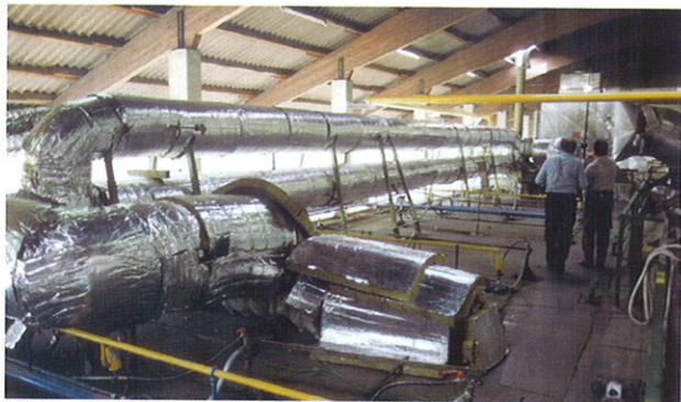
图3 在 eferding 的 bauhütte leitl 厂隧道窑碳化气体二次燃烧监测系统总貌
