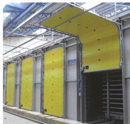
图 2 干燥室的内部
