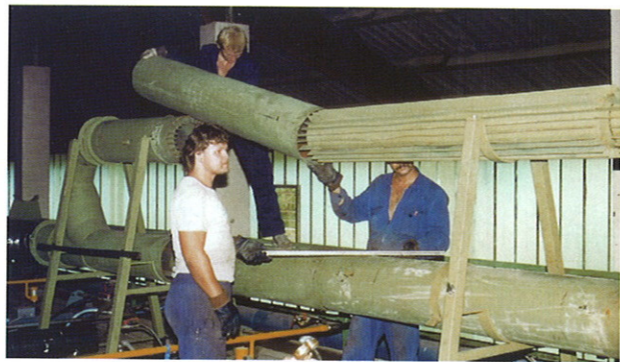
图5 在隧道窑顶上二次燃烧系统换热器环的安装
