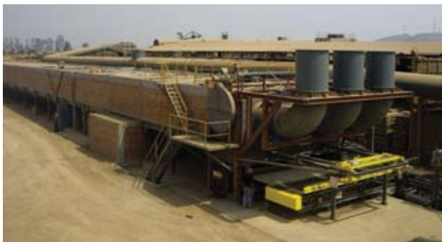
» 1 Скоростная сушилка компании Ceric на заводе Ladrillos Lark в Перу
