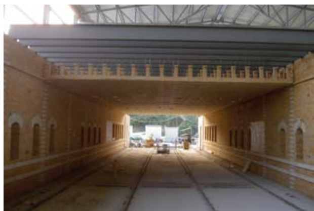
» 10 Строительство печи – сборка свода
