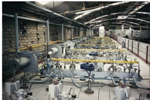
» 3 Установка Duplo-ASNG/2, работающая как на природном газе, так и на тяжелом топливе
