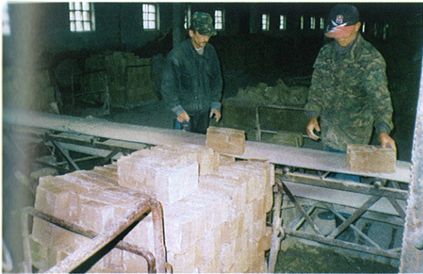
В печном цеху заготовки укладывают на стальные поддоны
