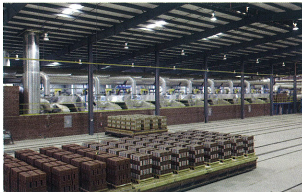
Рис. 9: Очередь 2 — сушильная камера
