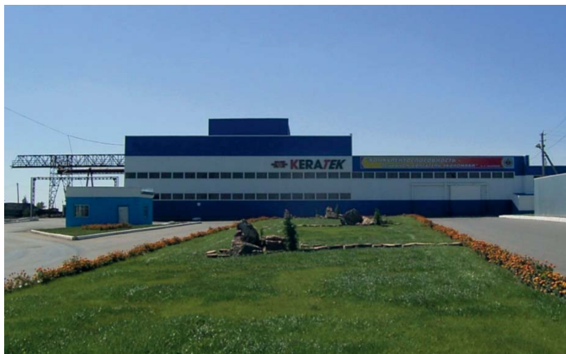
» Новый кирпичный завод Keratek LLP
