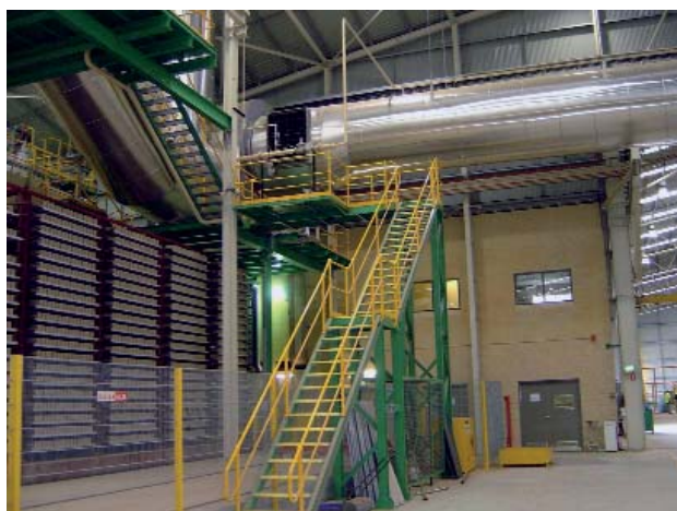
Рис. 4 Вентилятор горячего воздуха для сушилки
