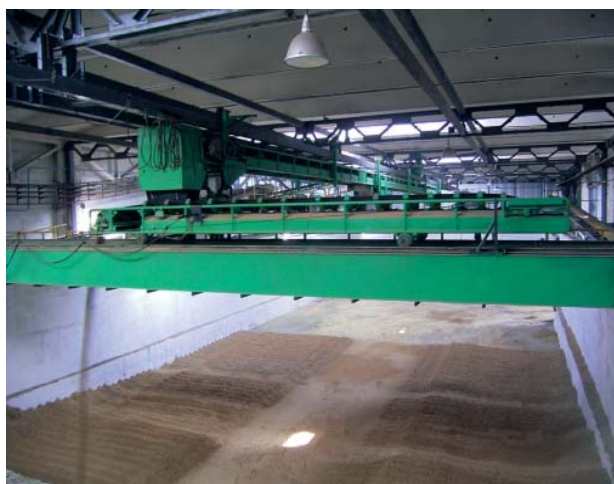
» В новой камере выдержки материал укладывается слоями и разгружается колесным погрузчиком
