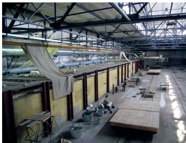
» Туннельная печь в процессе строительства
