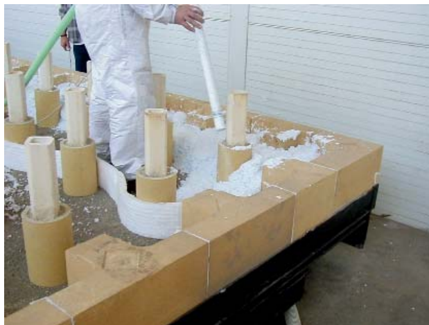
Рис. 3 Волокнистая пена позволяет полностью заполнять пустоты и, следовательно, быстро осуществлять сборку больших площадей
