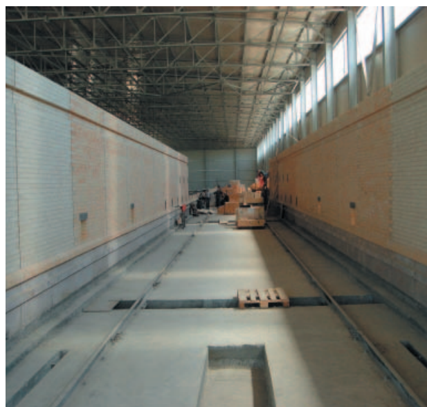
» Сооружение, монтаж и установка новой туннельной печи
