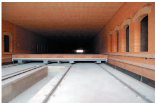
» Процесс строительства печи
