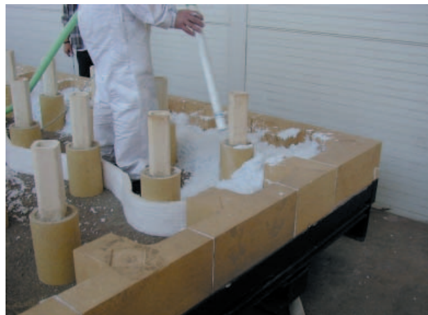
» 3. Волокнистая пена обеспечивает равномерное заполнение без щелеобразования
