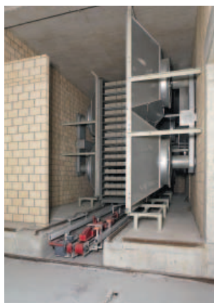
» Laminaris XL, вентиляционный модуль
