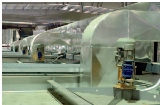
» 5 Приводные устройства оборудованы системой принудительного воздушного охлаждения для поддержания низкой температуры подшипников
