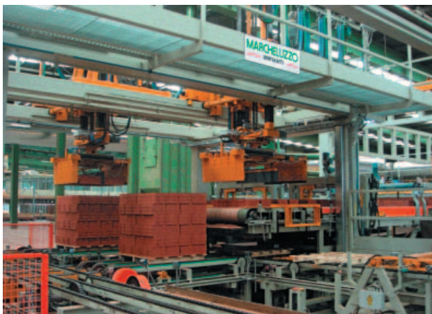
» 5 Линия формирования транспортных пакетов на деревянных поддонах, их упаковки в пленку для последующей отгрузки
