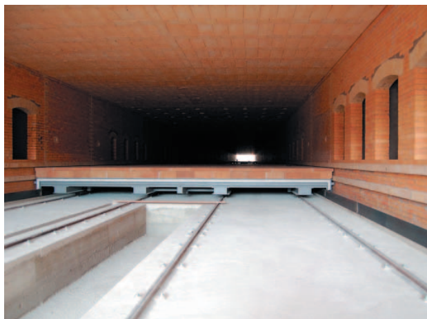
» Процесс строительства печи
