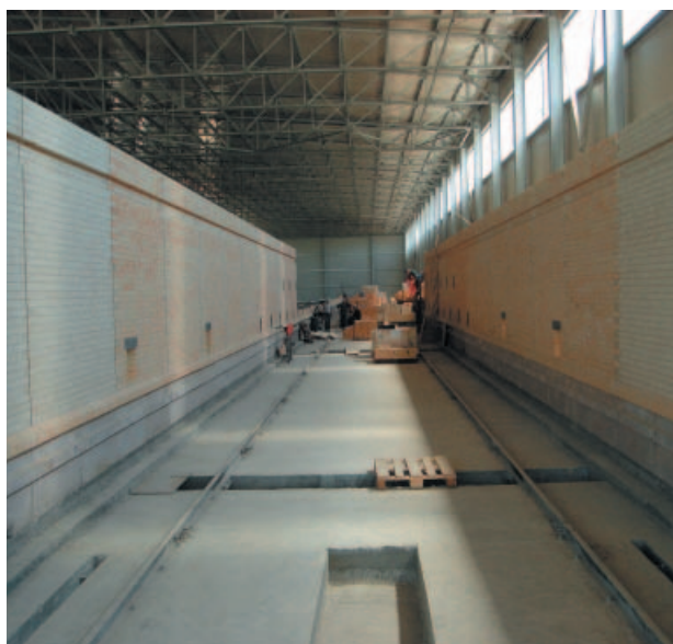
» Сооружение, монтаж и установка новой туннельной печи
