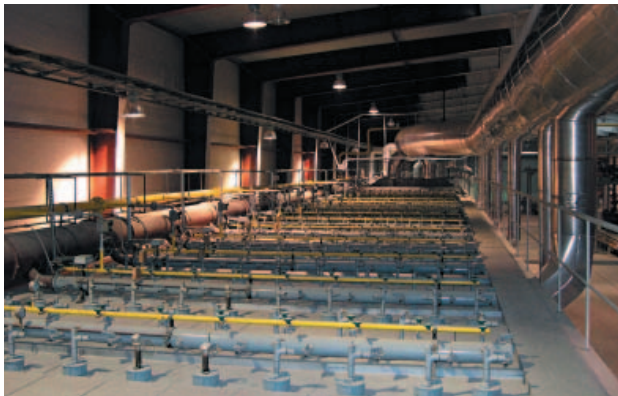
» 9 Установка сводовых горелок
