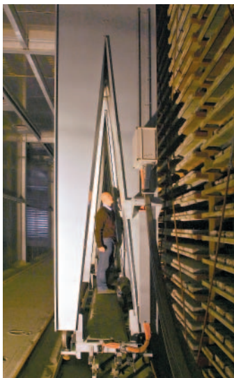
» 6 Мостообразная структура расположения вентиляционной группы обеспечивает беспрепятственный осмотр
