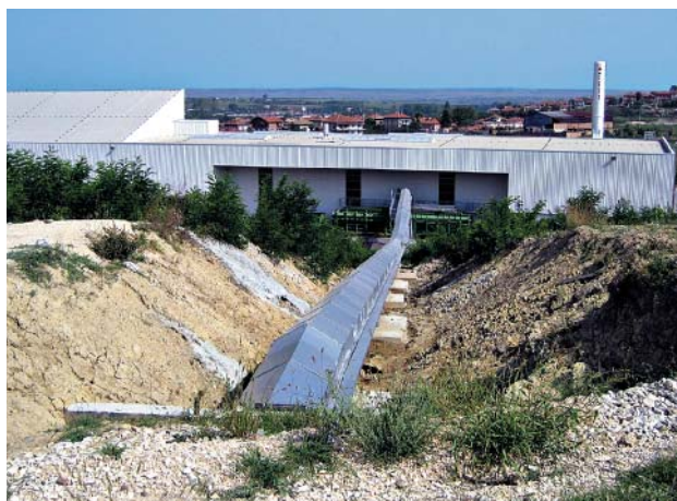
» 4 Конвейерная линия с кожухом для защиты от атмосферных осадков – на заднем плане справа участок массоподготовки, слева здание шихтозапасника для вылеживания глины с покатой крышей
