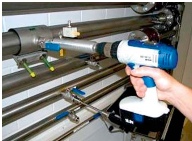
» 6 Монтрование соединения с помощью сверлильного оборудования к трубопроводу под давлением
