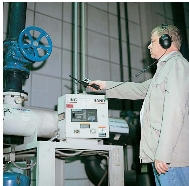
» 7 Ультразвуковой детектор-течеискатель LD 300 позволяет определить местонахождение утечек
