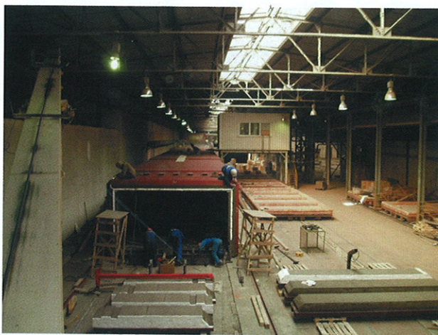
» 1 Кейзинговая печь на стадии монтажа
