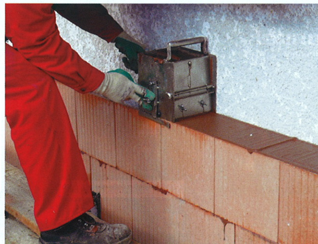
» 3 Укладка блоков производится по высокоточной технологии кирпичной кладки с тонкой растворной постелью и нанесением раствора при помощи салазок
