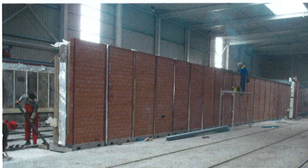
» 3 Сборка обжиговой печи модульной конструкции
