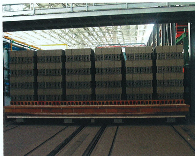
» 2 Печная тележка, загруженная перегородочными блоками
