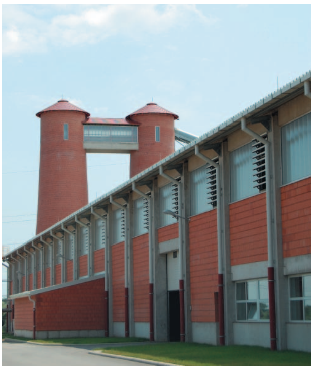
» 5 Отличительная особенность нового завода Csabai II – это 30-метровые башни для вылеживания сырья
