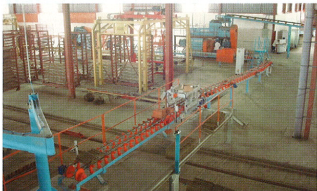
»6 Impianto di cottura forno
