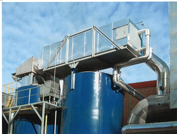
»2 Scambiatore di calore del tipo gas-acqua in un bypass caldo: fornisce energia supplementare per l'essiccazione
