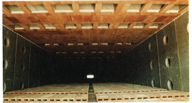
»5 Volta sospesa di forno realizzato da Coveri
