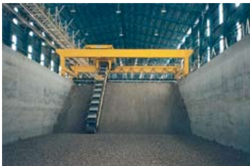
»1 Ageing house excavator Bel C »1 Sumpfhausbagger Bel C
